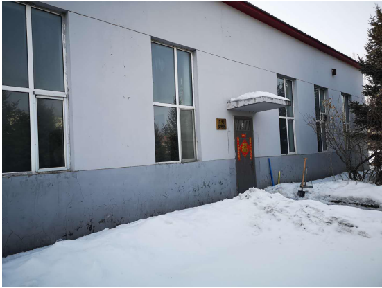
二水厂变电所
