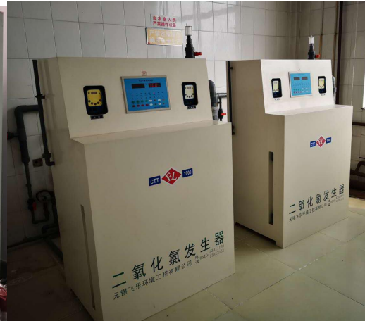
二水厂消毒间
